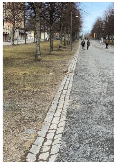
Kuva Hämeenpuiston keskikäytävän kivetystä hulevesikouru (FCG, 2023)
